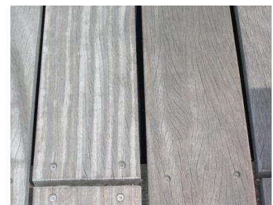
Bild 8: Für Wecheldrehwuchs typische Streifen – linkes Brett; fischgrätenartige Rissbildung – rechtes Brett.
