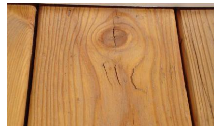
Bild 4: Schilfer – flächige Ablösung von Jahrringen bei der Fichte
