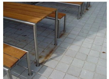
Bild 17: Verfärbung durch ausgewaschene Holzinhaltstoffe z. B. Bangkirai oder Esche
